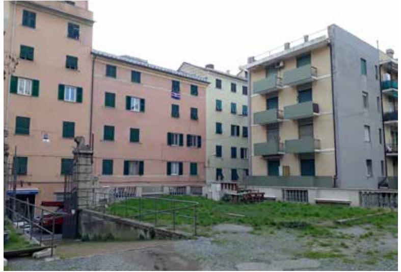
Dettaglio del giardino posto a est e degli edifici che vi si affacciano
