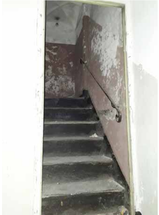
Vista del degrado delle superfici parietali interne
