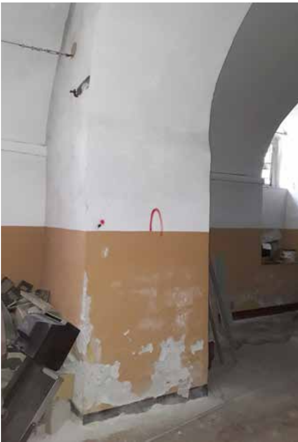
Vista dei locali posti nel piano seminterrato
