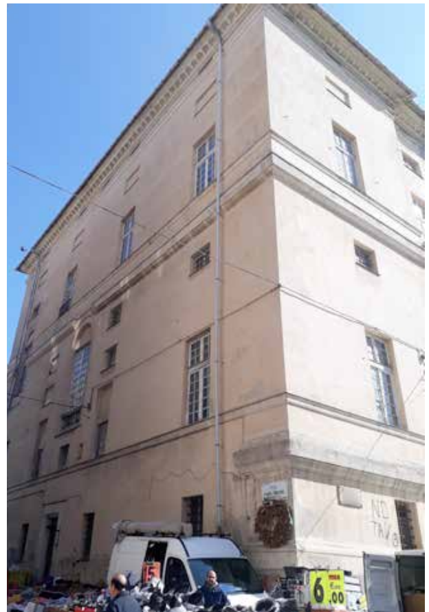
Particolare dell'angolo sud ovest da via Pirlone
