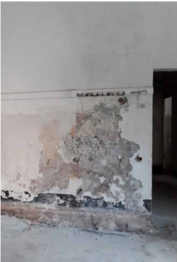
Vista del degrado degli intonaci interni al piano seminterrato
