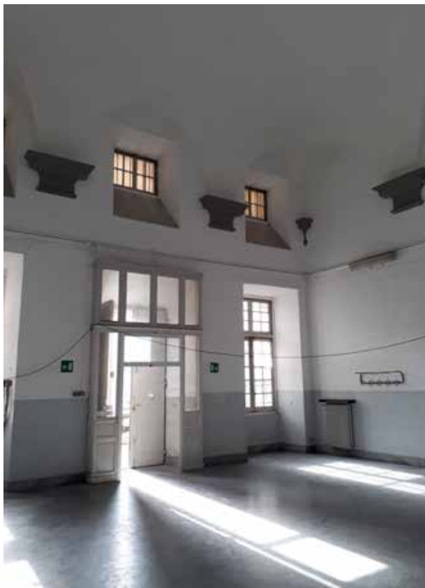
Vista dell'ingresso al piano terra
