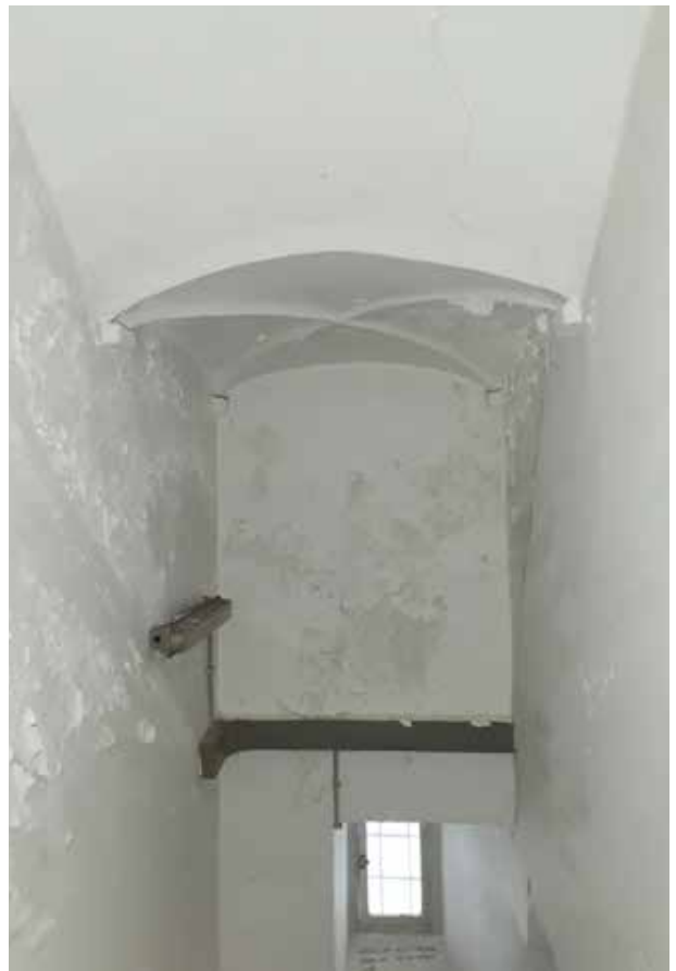
Vista delle esfoliazioni degli intonaci interni
