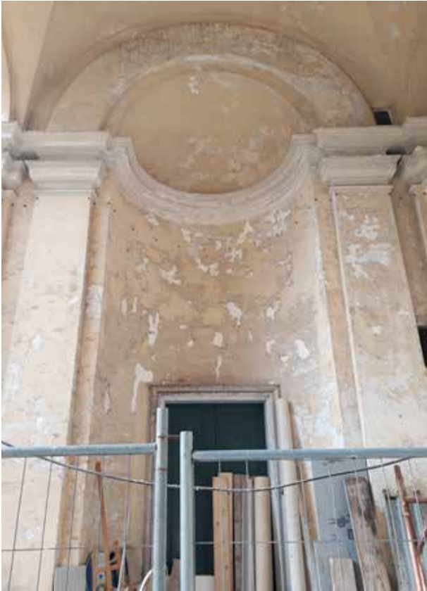
Vista del degrado degli intonaci della loggia esterna a est
