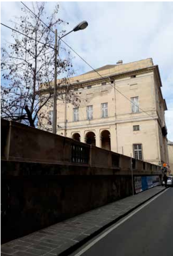
Vista del fronte est da via Daste
