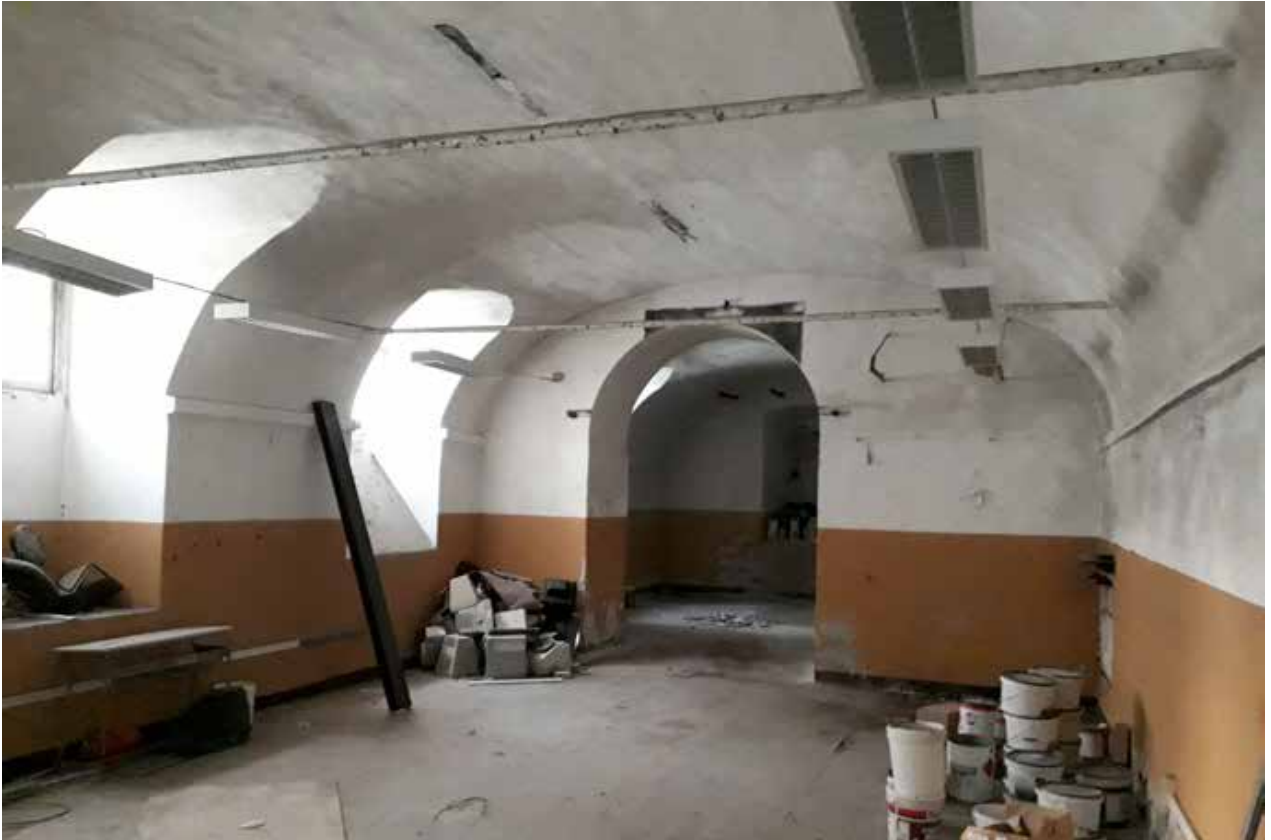
Vista dei locali posti nel piano seminterrato
