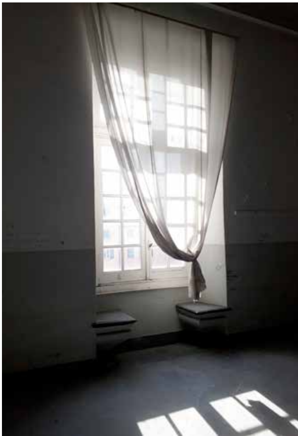
Dettaglio di una finestra in una stanza al primo piano
