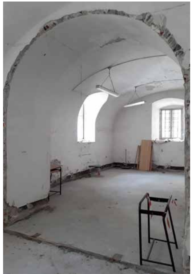
Vista dei locali posti nel piano seminterrato
