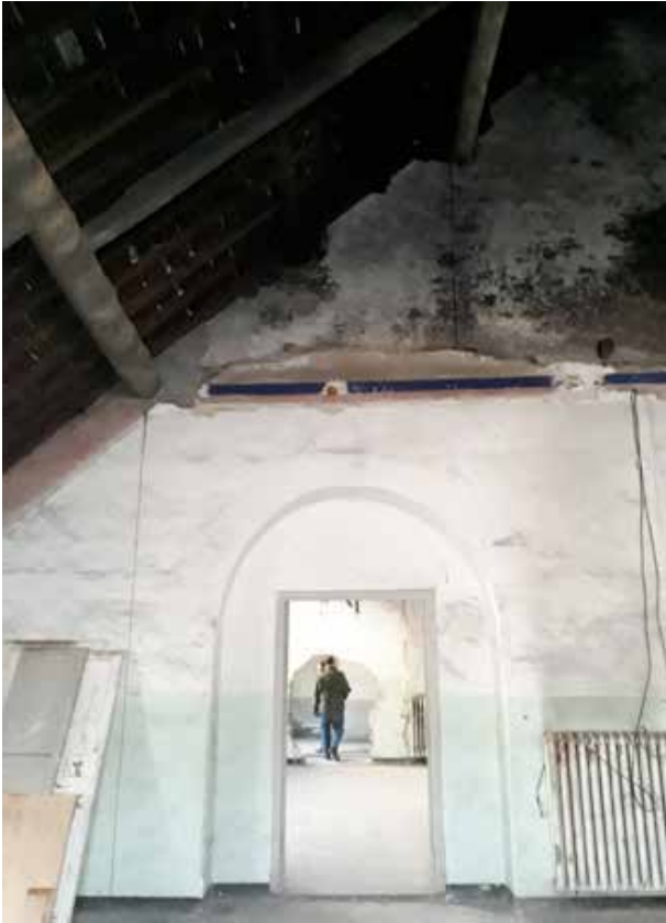
Vista degli ambienti mansardati posti al secondo piano
